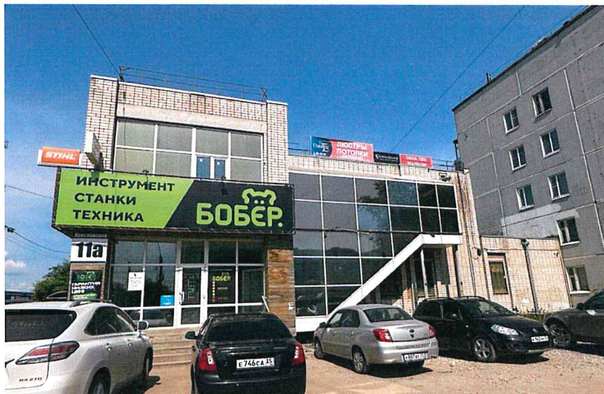
Фотографии фактического состояния фасада с указанием даты (фототаблица)
