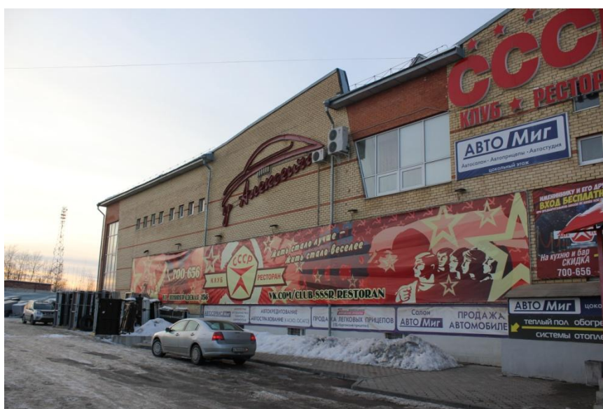
Фотографии фактического состояния фасада с указанием даты (фототаблица)
