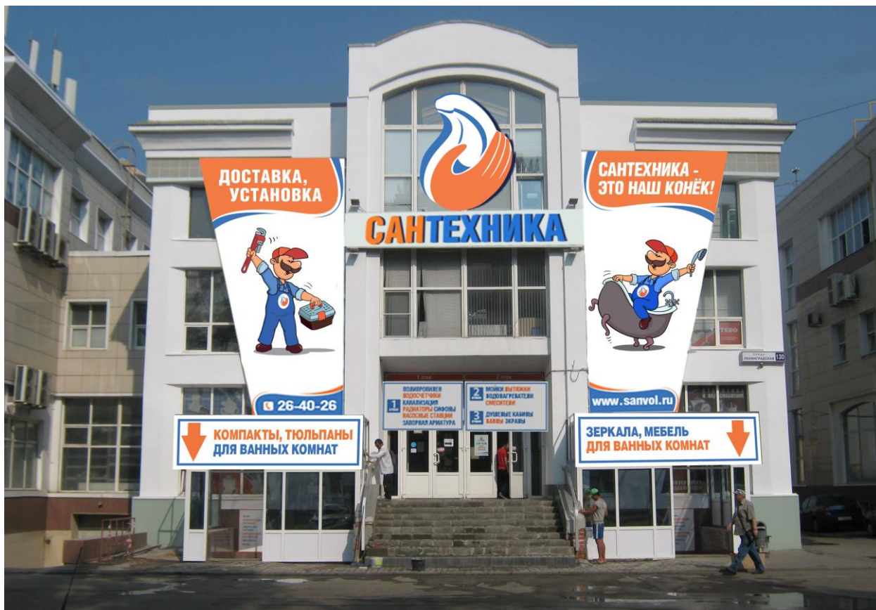
Фотографии фактического состояния фасада (на 06.08.2017)
