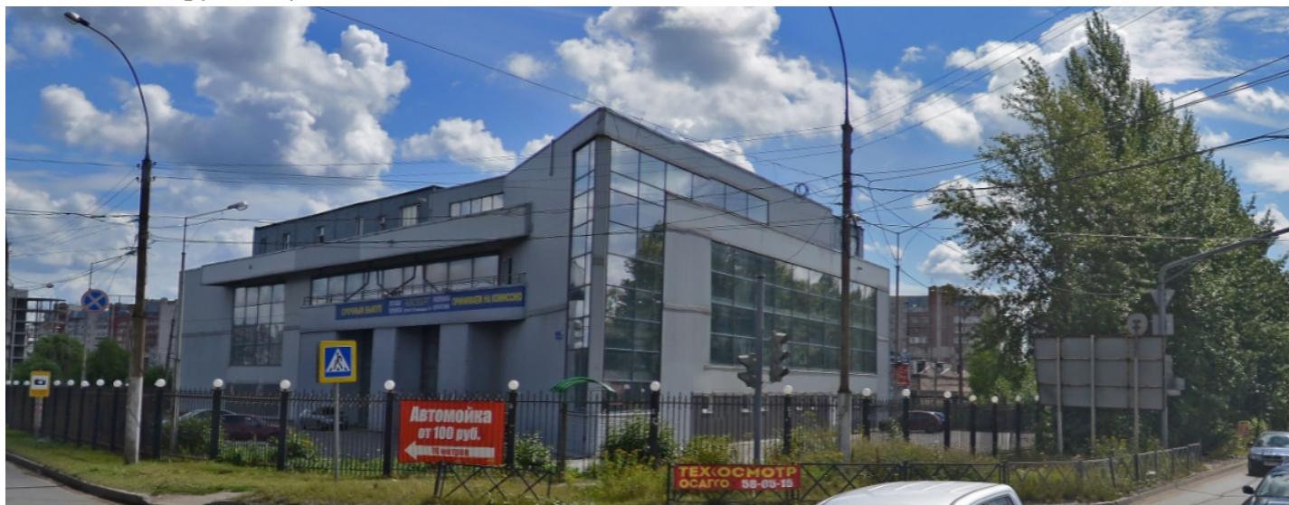
Фасад по Окружному шоссе.
